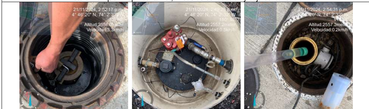
Foto 4. Tanque 2. Spill container, líneas de conducción y caja contenedora
