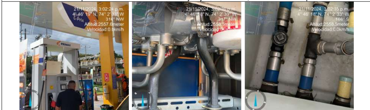
Foto 47. Dispensador 2 líneas de conducción y caja contenedora, en buen estado aparente
