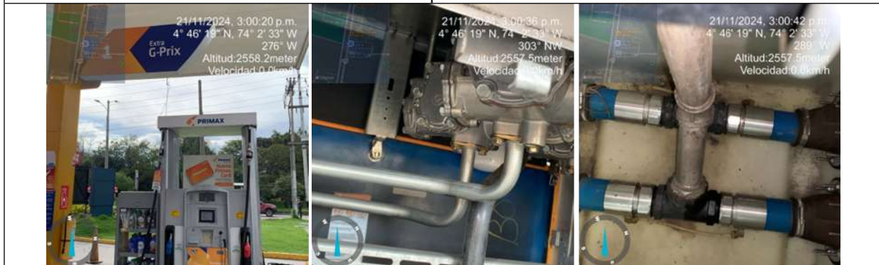
Foto 46. Dispensador 1 líneas de conducción y caja contenedora, en buen estado aparente
