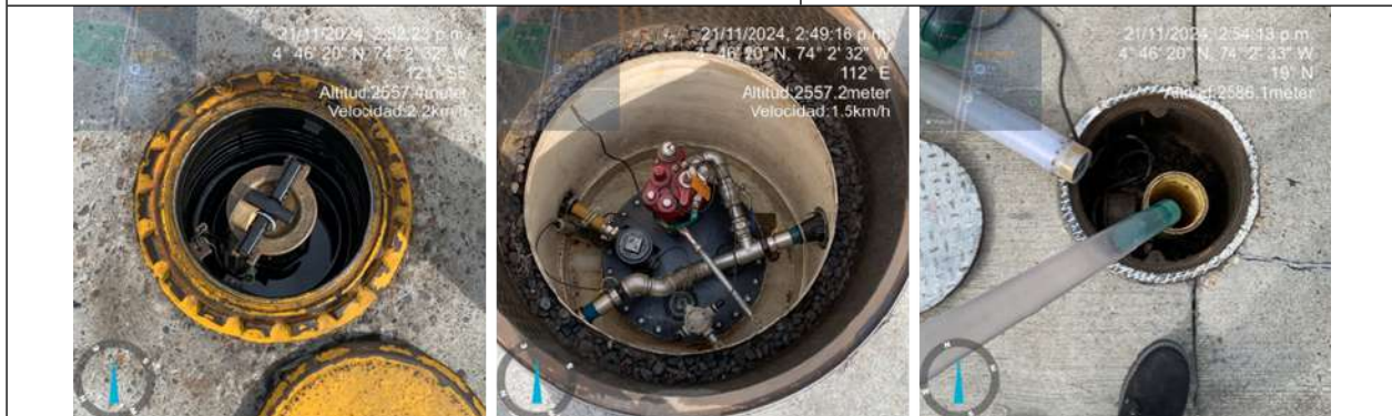
Foto 3. Tanque 1. Spill container, líneas de conducción y caja contenedora
